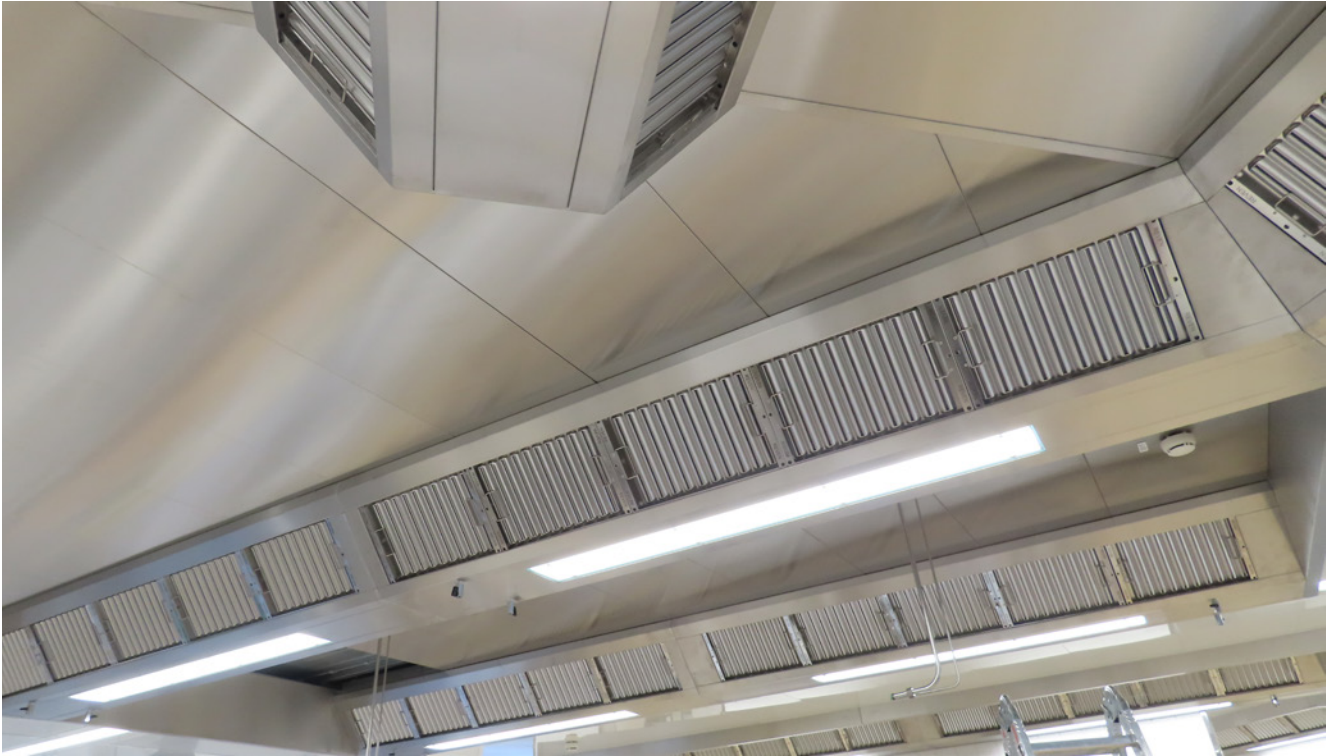
REVEN Lüftungsdecke
