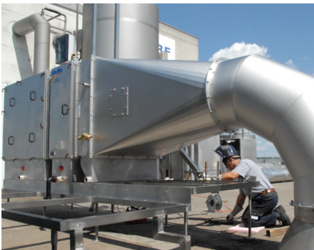
Montage eines REVEN Kanalabscheiders in der Lebensmittelindustrie
