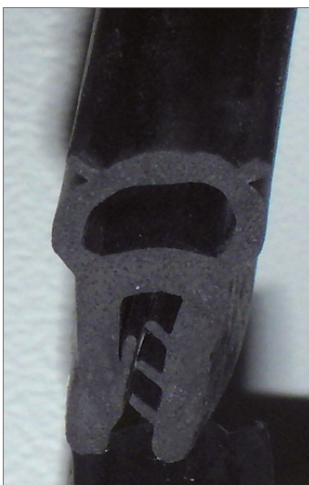
Abb.: Dichtungslippen in Großaufnahme
