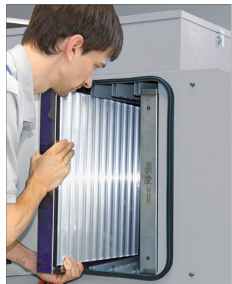
Abb.: Beim Einbau müssen die Filterprofile vertikal angeordnet sein.
