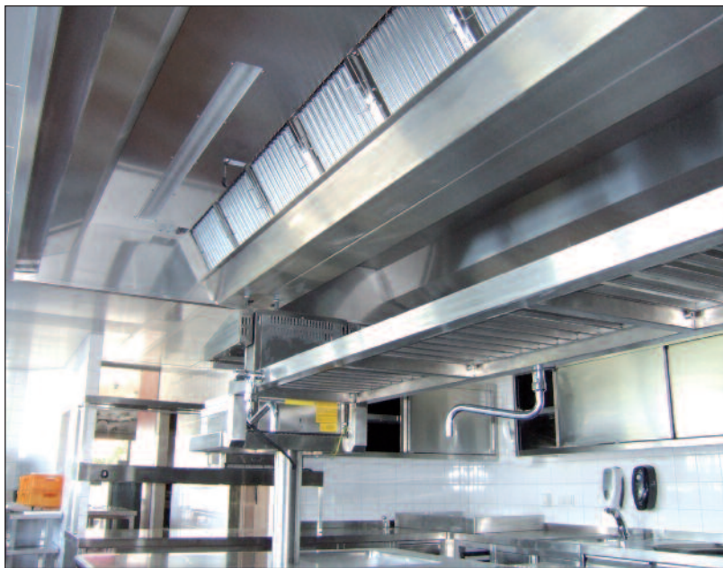
Abb.: Induktion mit 50% Zuluft Fig.: air induction with a supply air rate of 50 %
